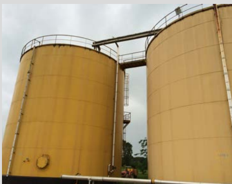
Photo 3 : Usine de PALMCI à Divo © 2014
