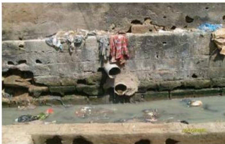
Photo 29 : Raccordement des tuyaux d'évacuation des eaux – vannes au caniveau ouvert des eaux pluviales © 2014
