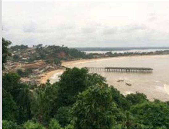
Photo 6 : Le wharf de la baie de Sassandra ©2014
