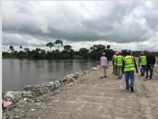
Photo 9 : Site de construction du Barrage © 2014
