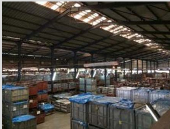
Photo 5 : Hangar de stockage de la SOGB ©2014
